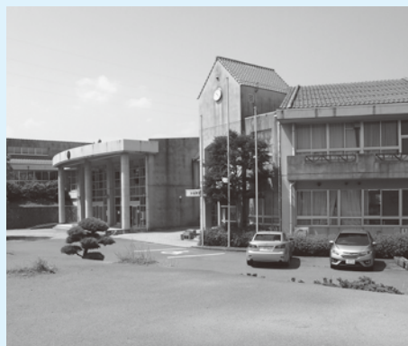
空調が新設される中山中学校
