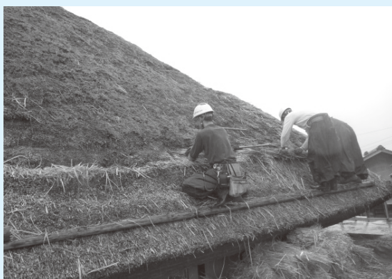
重文門脇家住宅屋根葺替の様子
