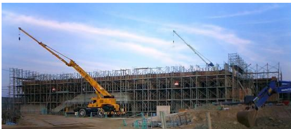
建設中の名和小学校新校舎
