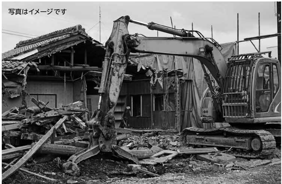
行政代執行が行われると、解体等処理にかかった費用が所有者に請求されます。
