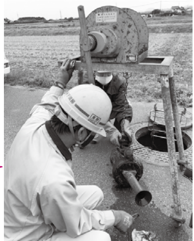
▲マンホールポンプを引き上げ、ゴミの取出し作業中
