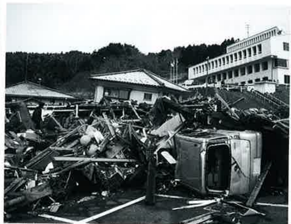
▲がれきの撤去はまだまだ続く（石巻市）
