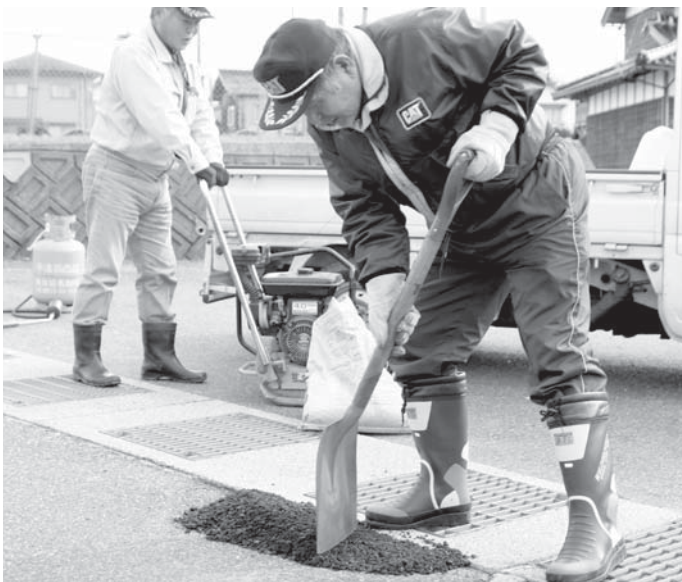
緊急雇用創出事業で町道を修繕
