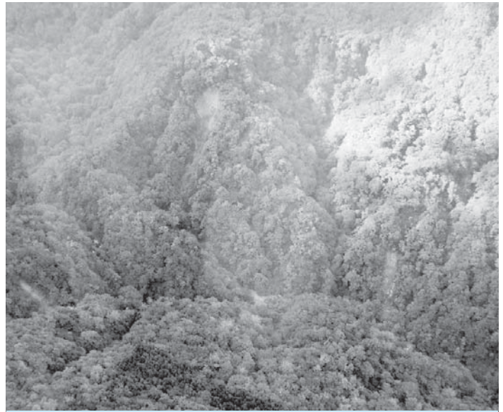
うぐいす橋上流の崩落現場
