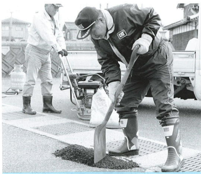
緊急雇用創出事業で町道を修繕
