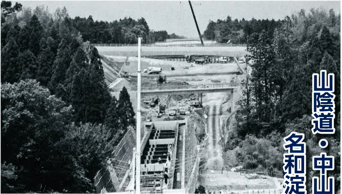
▲名和淀江道路宮川橋付近工事状況（県道高橋下市停車場線より西向き）
