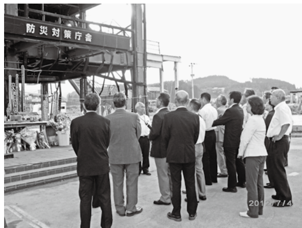
多くの役場職員が犠牲となった防災対策庁舎
