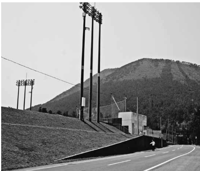
目視による点検では不十分な照明施設
