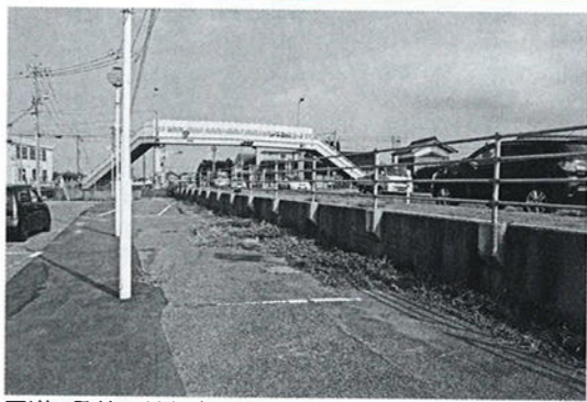
国道9号線の拡幅(塩津交差点)
