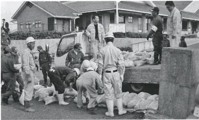
▲大山町建設業協議会・大山町消防団による土のう設置の様子
