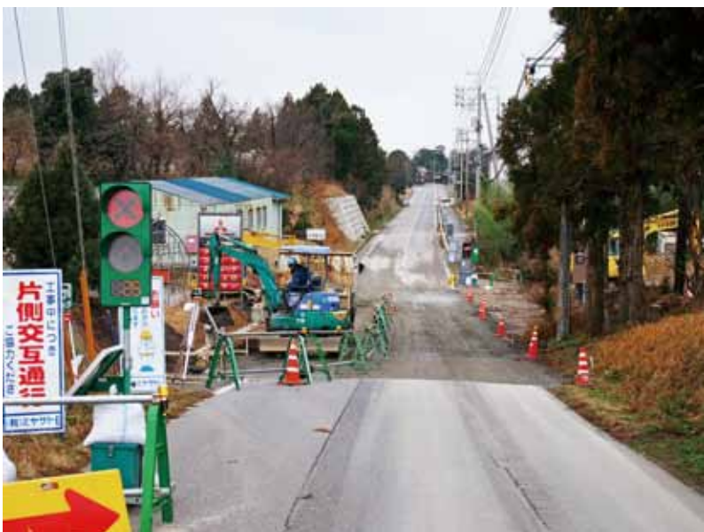
町道の拡幅工事
