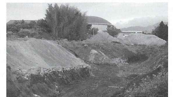
造成中の保育所用地(名和中学校南側)
