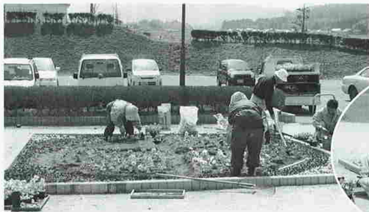
仁王堂公園での作業
