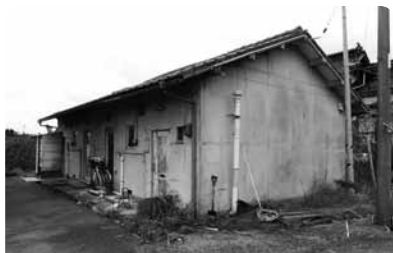
解体する町営住宅
