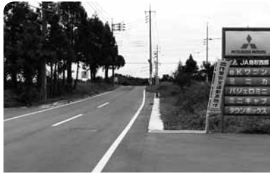
改良が進む道路
