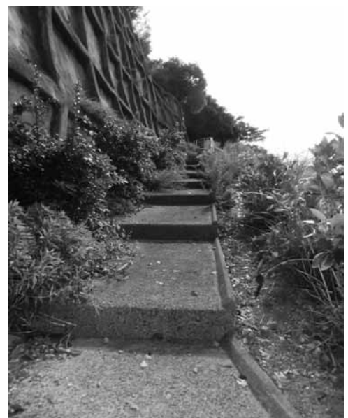
本庁舎裏手に続く避難路(御来屋)
