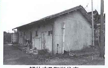
解体する町営住宅
