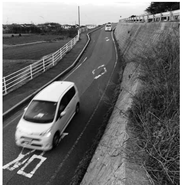
狭い町道(町道中山小学校線)
