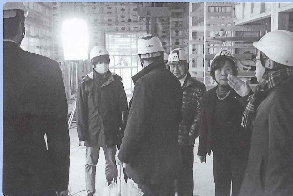
建設中の名和さくらの丘保育園
