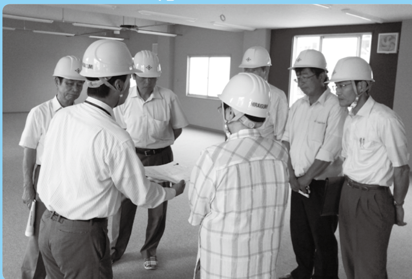
改修中の現場を視察
