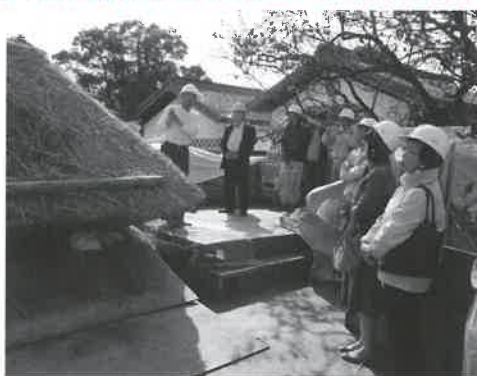
▶間近で葺替え現場の見学
