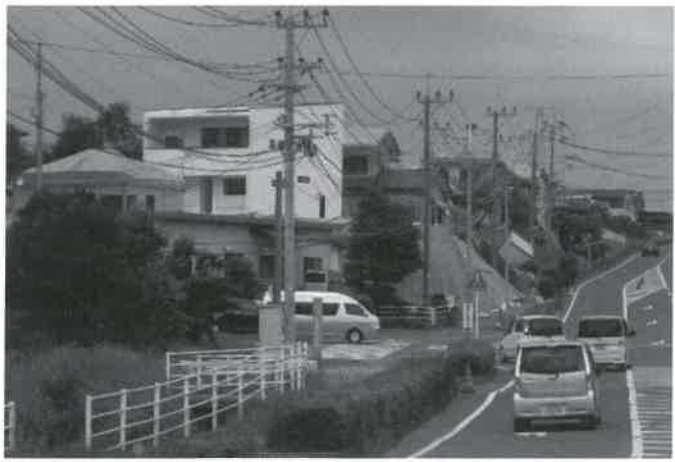
▶震災後1か月がたってもブルーシートに覆われたままの家屋が目立つ(益城町)
