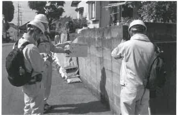
▶判定作業の様子
