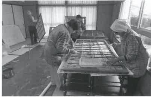
▲慣れた手つきで障子の張替作業
