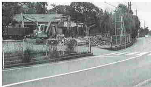
県道工事で取り壊される庄内地区集会所
