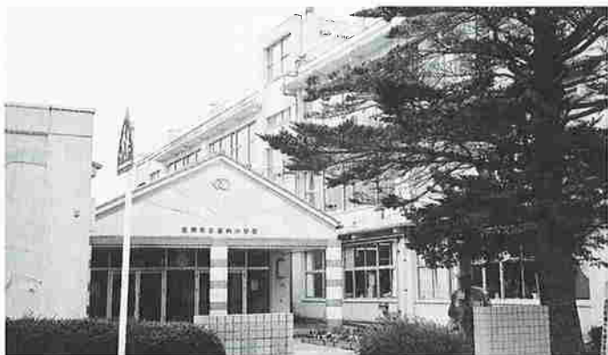
名和小の仮設校舎が建てられる庄内小学校
