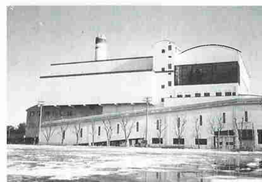
米子市クリーンセンターの活用が鍵
