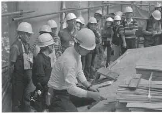
▲屋根の葺き替え見学
