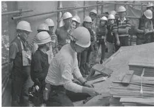
▲屋根の葺き替え見学
