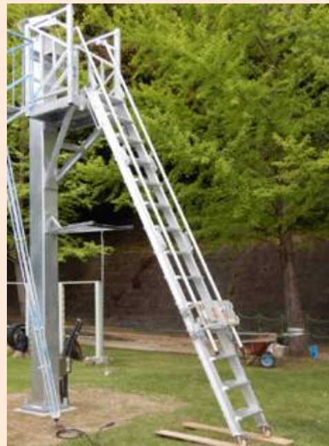
写真判定用の建物設置
