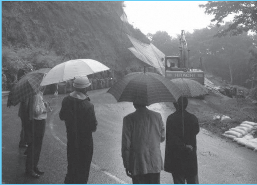
川床土砂崩れ現場
