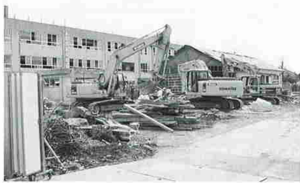
解体中の名和小学校
