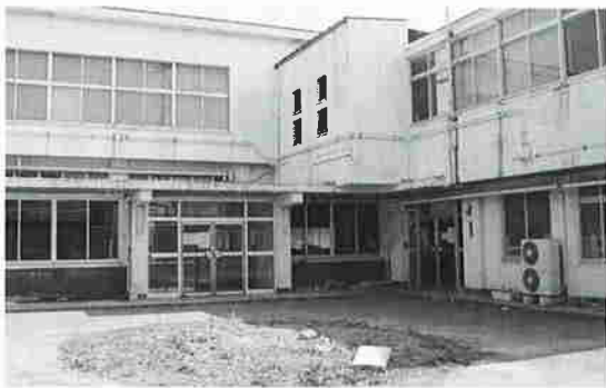
取り壊しを待つ旧大山町役場
