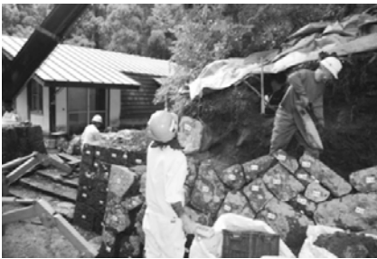
▲石垣解体の様子
