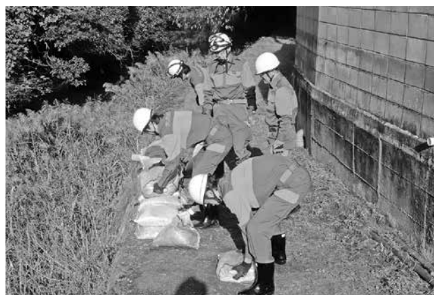
▲消防団による土のう設置（旧奈和）
