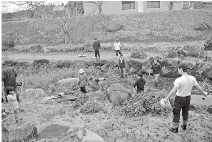
▶小川の流れをせき止めている草を取り除きました
