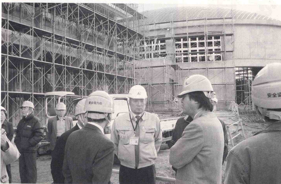
名和小学校建設現場を視察。後ろの円形屋根は体育館
