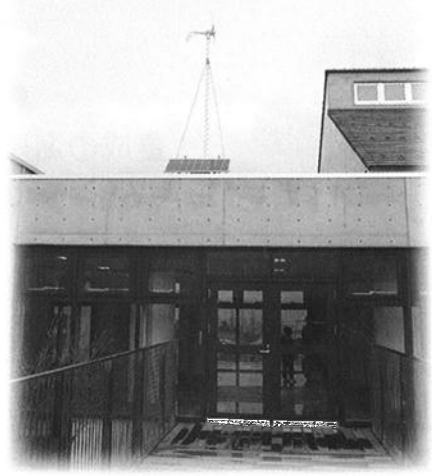
2階渡り廊下から見えるハイブリッド発電塔
