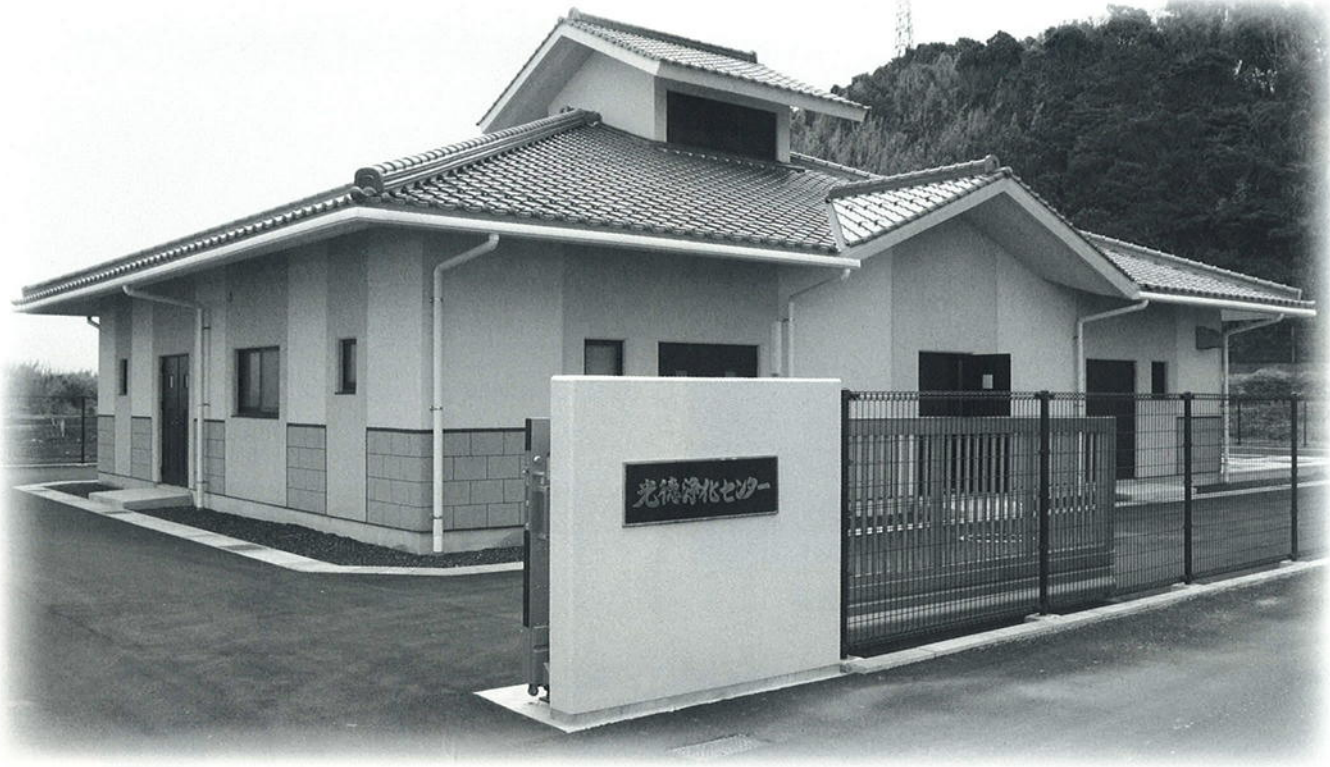
豊成の海岸沿いに完成した光徳浄化センター
