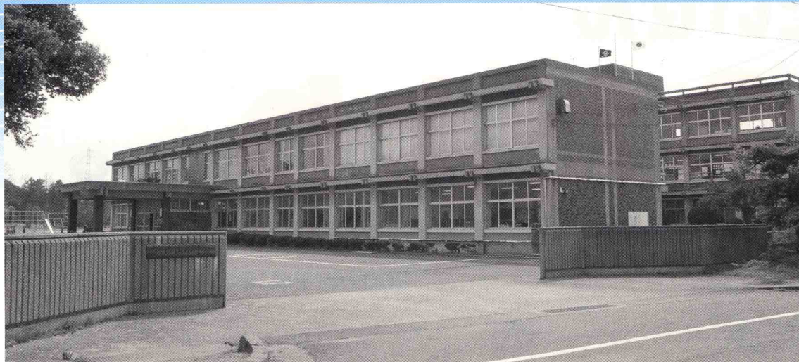
耐震工事が行われる中山小学校
