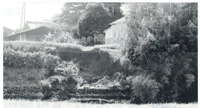
豪雨により崩れた畦畔 (八重)
