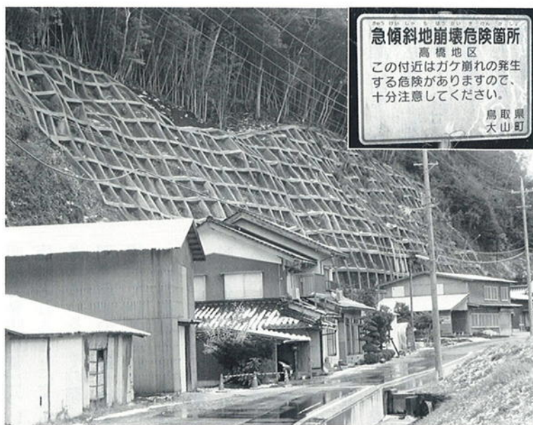
整備が完了した高橋地内急傾斜地
