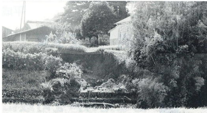
豪雨により崩れた畦畔 (八重)
