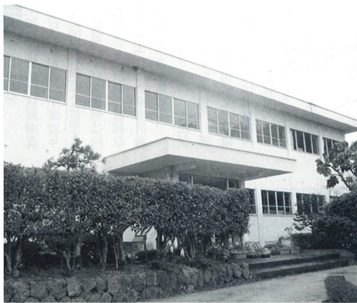
耐震化工事が議論された赤松分校
