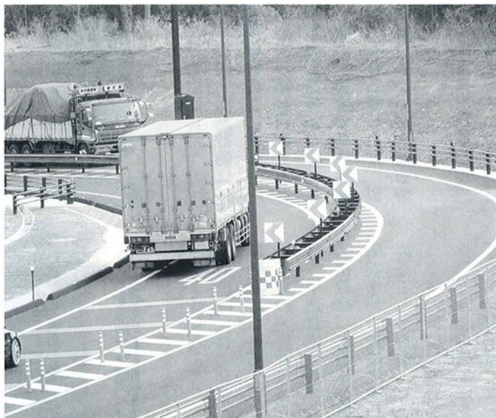
開通した山陰道名和インター付近
