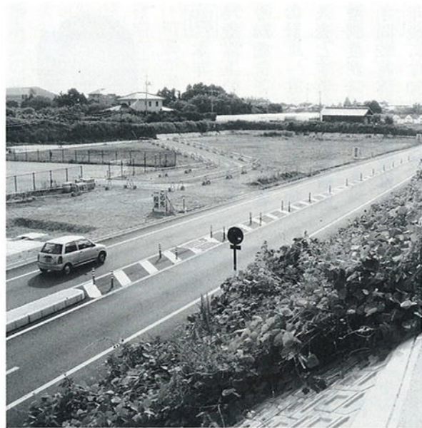
観光交流センター建設予定地
