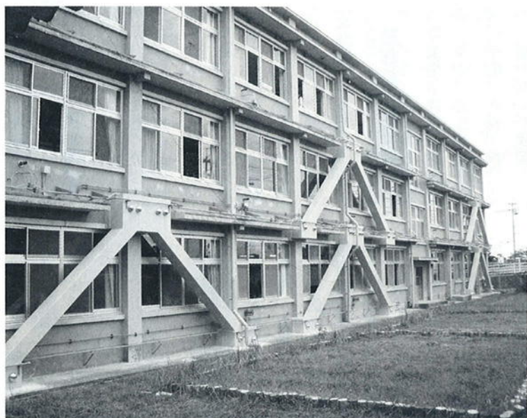
完了した名和中耐震補強工事
