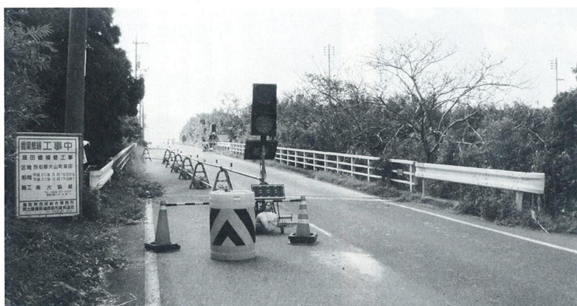
工事がはじまった高田橋
