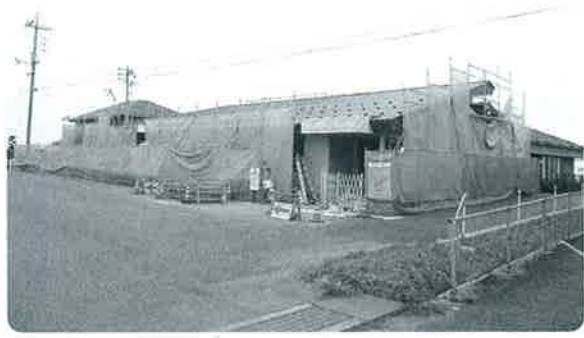
▲ 順調に工事が進む新しい『大山口診療所』
