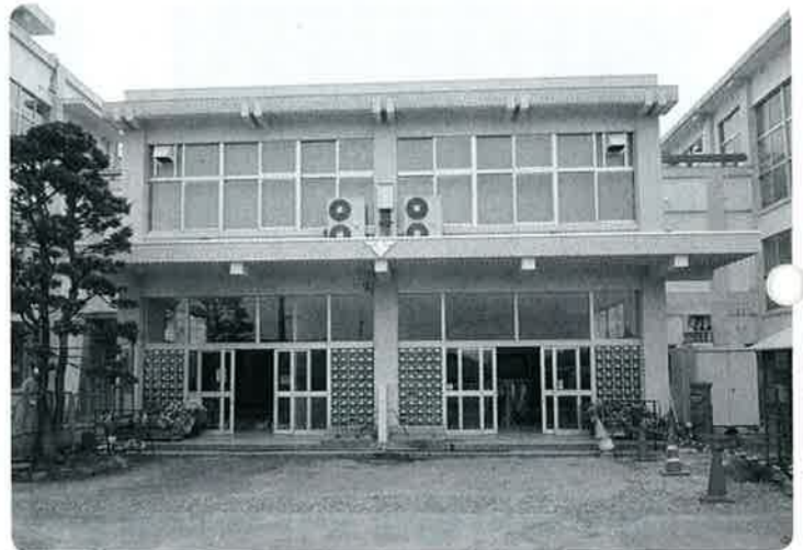
来客用玄関を向かって左側に設置
