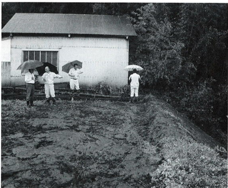
崩壊した水田の原形復旧を行った
